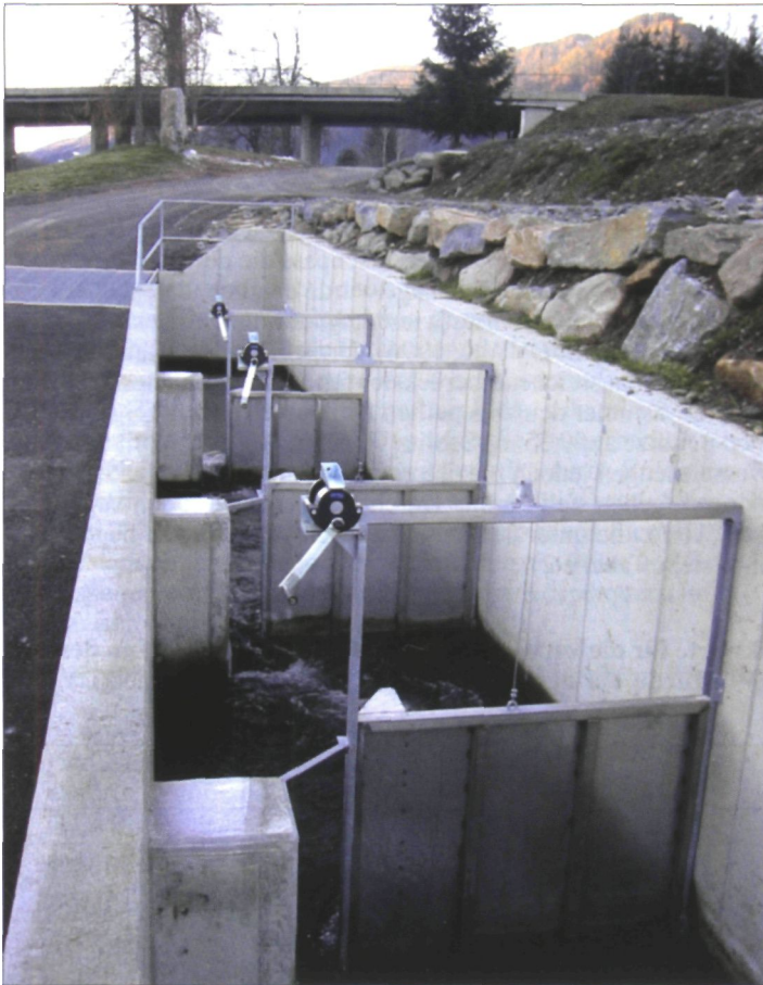
Abb. 5: Optionale Schlitz in den drei Vorbecken. Die Umlenkböcke sind fix geschalt und haben praktisch keinen Einfluss auf das Fließverhalten bei hochgefahrenen Trennwänden
